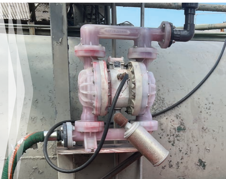
Hög sughöjd minskar pumpens kapacitet.
